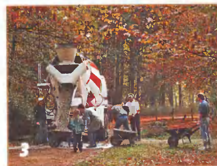
Въехать на крошечный участок тяжёлая техника не могла, поэтому раствор на стройплощадку пришлось доставлять ручными тачками.
