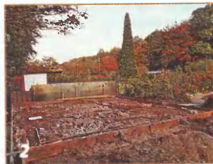
Площадка подготовлена под отливку фундамента — установлены опалубка и арматура.
