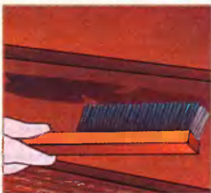
Рис. 7. Жёсткой металлической щёткой удаляют отслоившуюся краску и трухлявую часть дерева.
