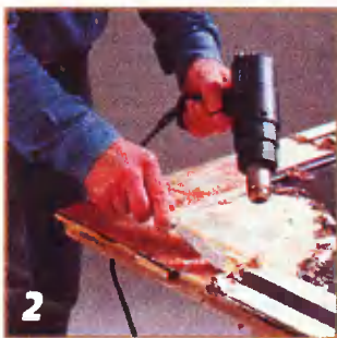
Рис. 6. Расплавить краску в короткое время можно лишь на небольшом участке обрабатываемой поверхности. Расплавленное покрытие следует сразу же удалить шпателем с одного участка, затем с другого и так далее.
