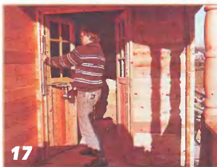
Заключительный этап строительства — установка дверей, оконных рам и внутренняя отделка.
