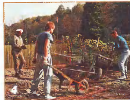
Несмотря на то, что укладка бетона осуществлялась вручную, эта работа была завершена в течение одного дня.
