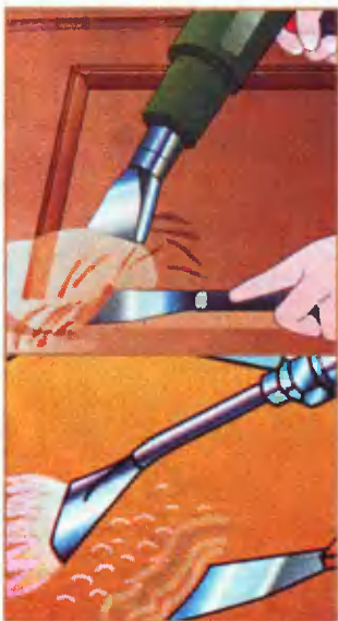
Рис. 6. Расплавить краску в короткое время можно лишь на небольшом участке обрабатываемой поверхности. Расплавленное покрытие следует сразу же удалить шпателем с одного участка, затем с другого и так далее.
