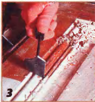
Рис. 9. Применение цикли с изогнутым лезвием. Краску удаляют одной из заточенных кромок цикли.
