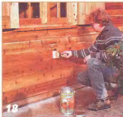
Полностью завершив работу с деревом, все стены покрасили масляным лаком.
