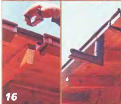
Для сбора дождевой воды смонтировали водосточные желоба.
